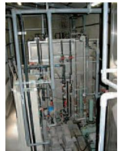
膜を利用した水の浄化装置
