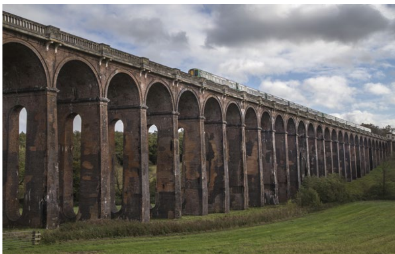
1841年建設の高架橋(英国)
