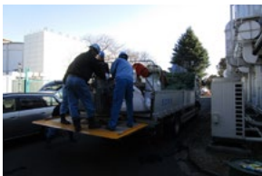
微量PCB廃棄物の搬出作業
