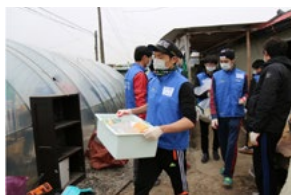
従業員が障がい者住宅の修繕ボランティアに参加
