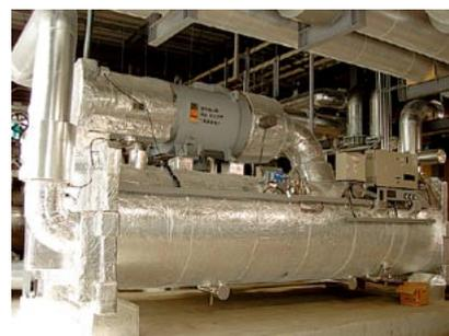
【富士通日立プラズマディスプレイに導入した季節により回転数を制御し高い効率で運転可能なインバータ付冷凍機】
