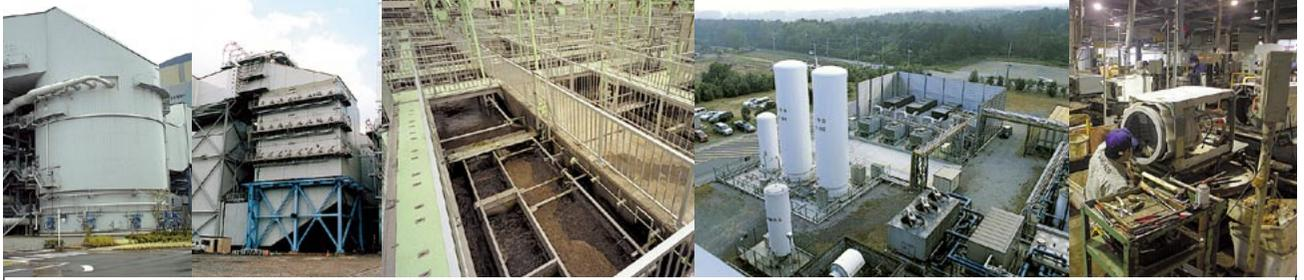
【排煙処理システム】大気汚染による酸性雨等の環境問題対策として、排ガス中の硫酸化物(SOx)、窒素酸化物(NOx)を除去する排煙処理システムを提供
