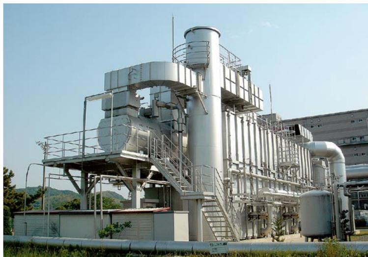
【日立マクセルに導入した蓄熱方式VOC燃焼装置】
