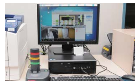
リモートによるコンテナ型データセンターの監視風景
