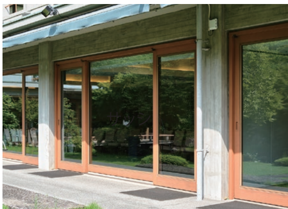
劣化が進んでいた桧のサッシは、改修時にアルミサッシへの変更が検討されたが、コの字のアタッチメントを付けて複層ガラスを入れることで再利用が可能になった。
