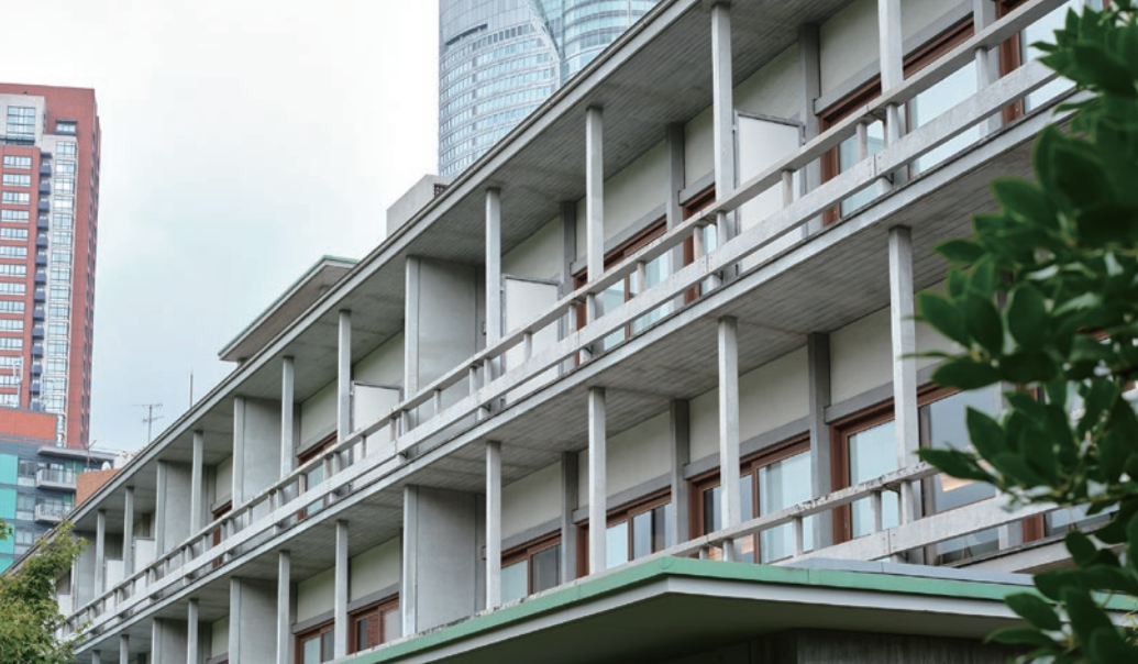
連続した柱と梁が作り出す、各部屋の深い軒先が特徴的なプレキャスト・コンクリート工法。
