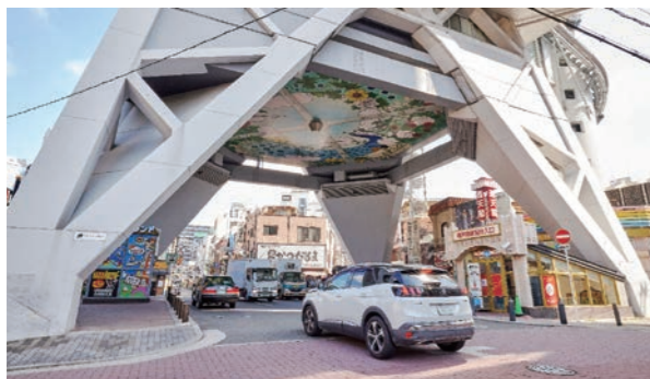
市道を跨いで建つ通天閣。塔脚の間は24mとタワー建築にしては狭い。初代通天閣が近隣からの出火で被災した教訓から鉄骨をコンクリートで耐火被覆した
