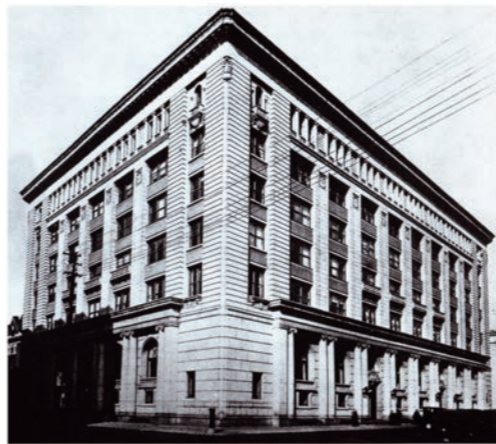
留学から帰国した内藤多仲が自身の耐震構造理論の実践を試みた日本興業銀行本店。1923年竣工、設計は渡辺節。鉄骨鉄筋コンクリート造（現存せず）
