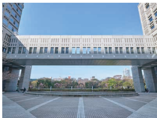
職員が行き来しやすいよう、各棟は空中歩廊でつながっている。写真は第一・第二本庁舎の3階をつなぐ部分
