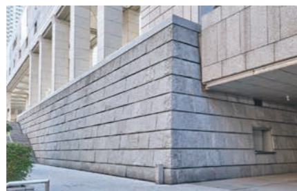
第一本庁舎1階の外壁。外装材に江戸切り目地という仕上げを施すことで、伝統的な石積みみの重量感を表現している
