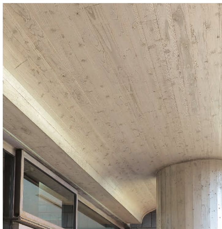
外部の柱や庇、地上階の柱や梁の打ち放しコンクリートは、杉板の特殊型枠で成形。美しく転写された杉板の木目が、本来は無機質なコンクリート面の表情に温かみを持たせている
