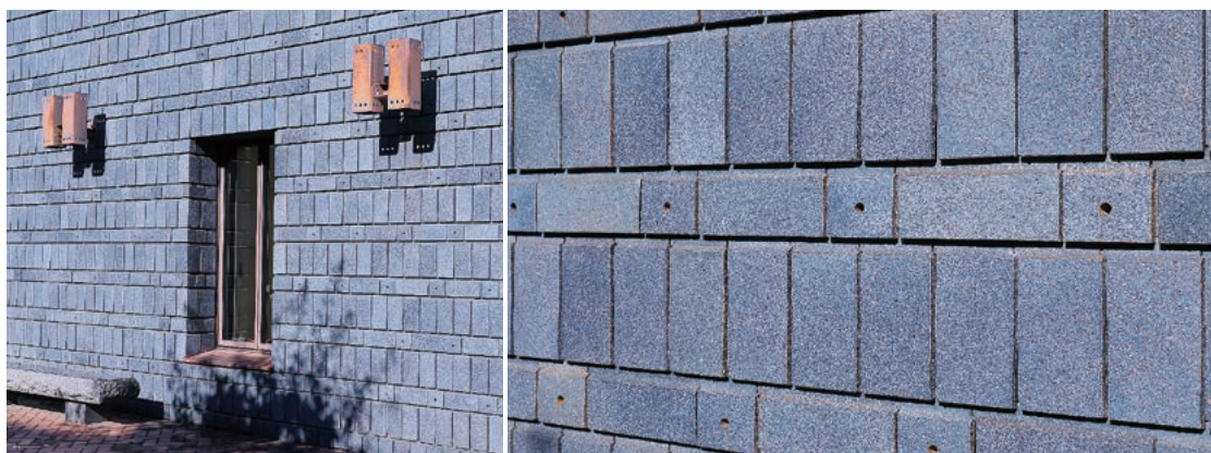
新館の外壁は、外光を調節するルーバーの働きを持った穴あきのプレキャストコンクリートにタイルを打ち込んだもの。外断熱の効果があり、美術館の建築に用いられることが多い
