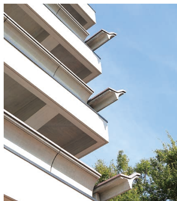
本館のテラスの四隅には、プレキャストコンクリート製の太い手すりが互い違いに飛び出している。前川國男が設計した京都国会館にも見られる寺社建築の高欄を意識したデザインだ
