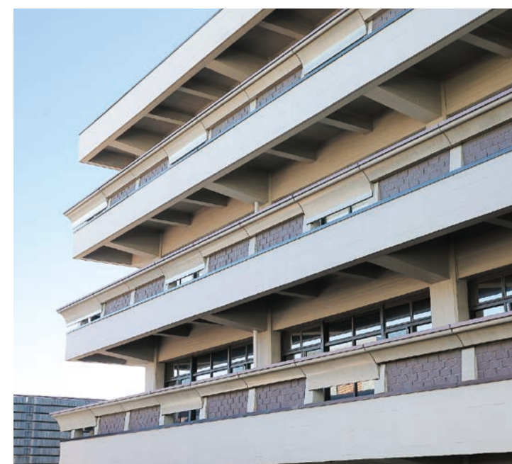
本館の各階のテラスには一直線にプレキャストコンクリート製の手すりが伸びる。前川國男にとって「手すり」は建物の水平性を強調する言葉であり、建築を構成する重要なデザイン要素だった
