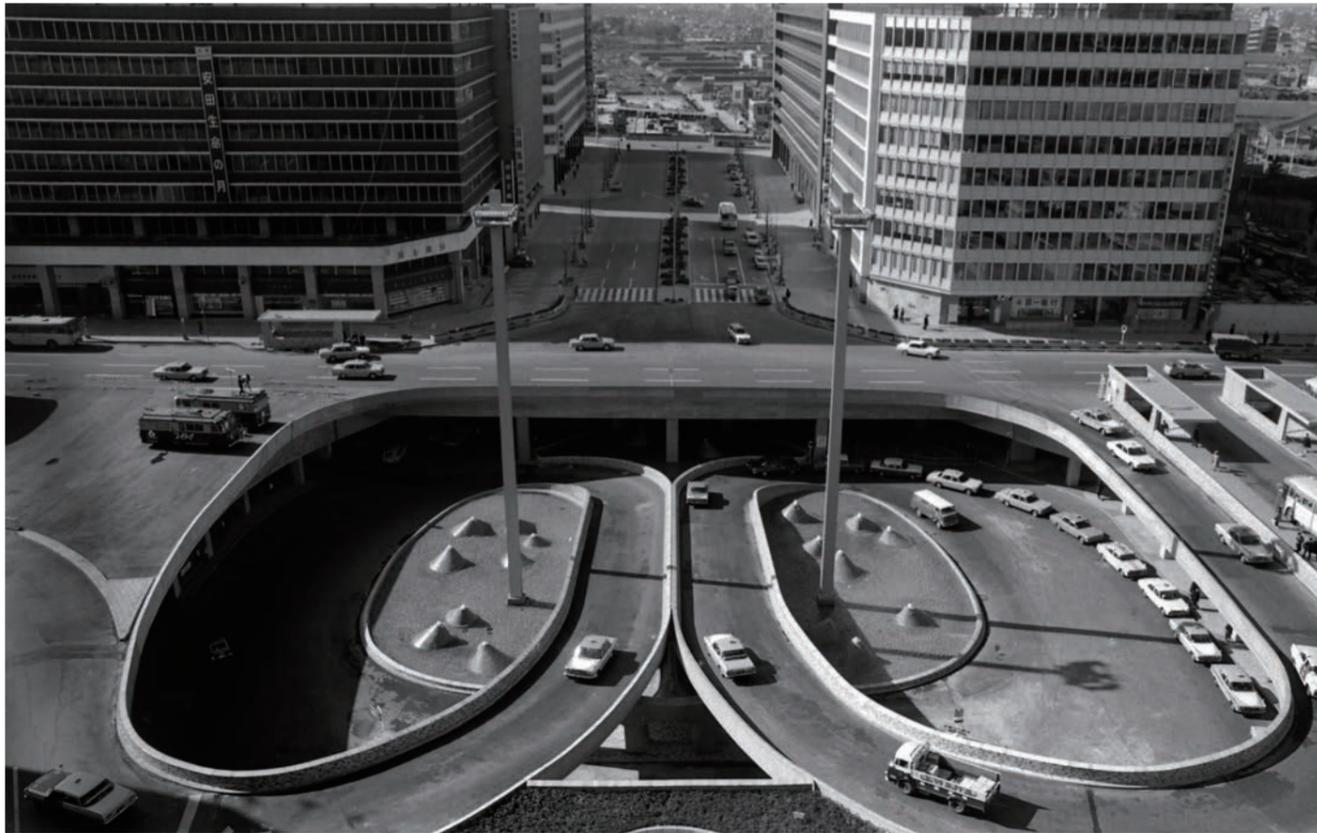
竣工時の小田急百貨店側から見た中央開口部。螺旋状のスロープは地下1階のロータリー、さらに地下2階の駐車場へと続く車路になっている。螺旋状のため十分に緩やかな勾配にできるうえ、専有面積も小さくて済む。また、自動車の動線の中央にこのスロープがあることで、地上も地下も自動車の交錯を避けられるしくみになっている(写真:新建築社写真部)
