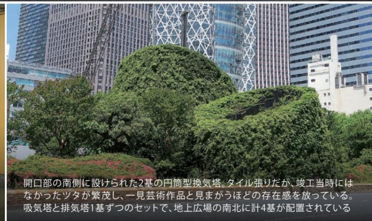
開口部の南側に設けられた2基の円筒型換気塔。タイル張りだが、竣工時にはなかったツタが繁茂し、一見芸術作品と見まがうほどの存在感を放っている。吸気塔と排気塔1基ずつのセットで、地上広場の南北に計4基が配置されている
