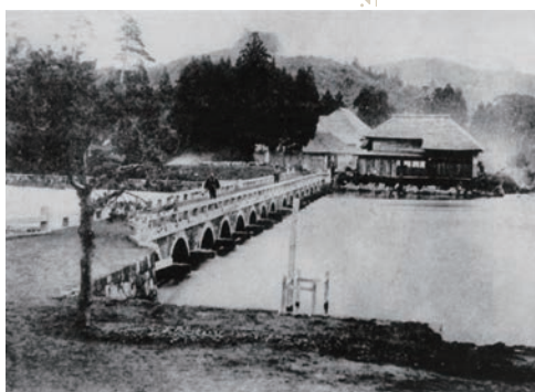
安積疎水事業の一環としてつくられた十六橋水門 写真提供/郡山市
