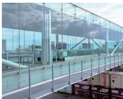
ガラス清掃のためメンテナンス・デッキは、内側からの視線を遮らないよう通路の床より低い高さに設置されている。
