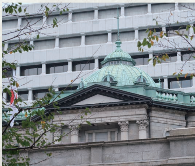
本館のシンボルであり、辰野金吾の建築で多く見られるドーム。石造の外観の中央に位置し、建物を特徴づけている。ドームは関東大震災で焼失した後、改修された。
