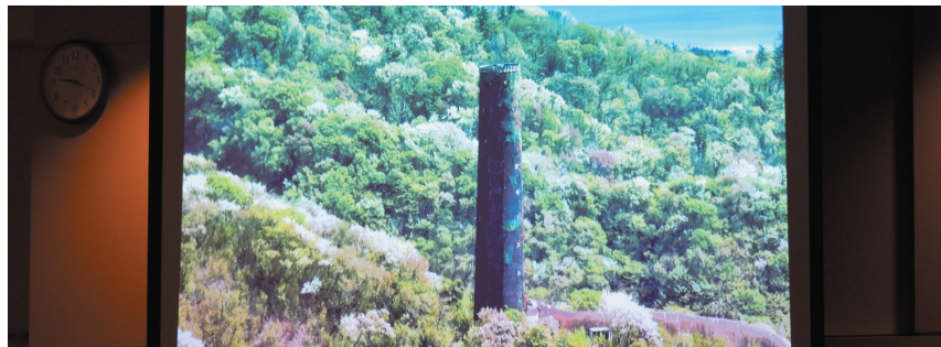
高さが3分の1になった現在の大煙突。「この大煙突には、企業と地域住民との共存共栄の思いが刻み込まれているんですね。経年劣化で倒壊したとき、もし谷側に倒れたら被害が出ていたけれど、うまく山側に倒れて被害がなかったそうです。篠原館長によると、万一のときには山側に倒れるような構造にしてあったのではないかと、という説もあるとか。当時の技術者魂を想像すると、ありえない話ではないと思いますね」（松井氏）
