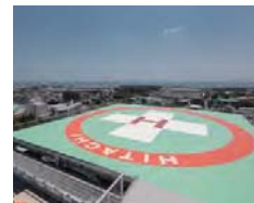
▲ 屋上ヘリポート
