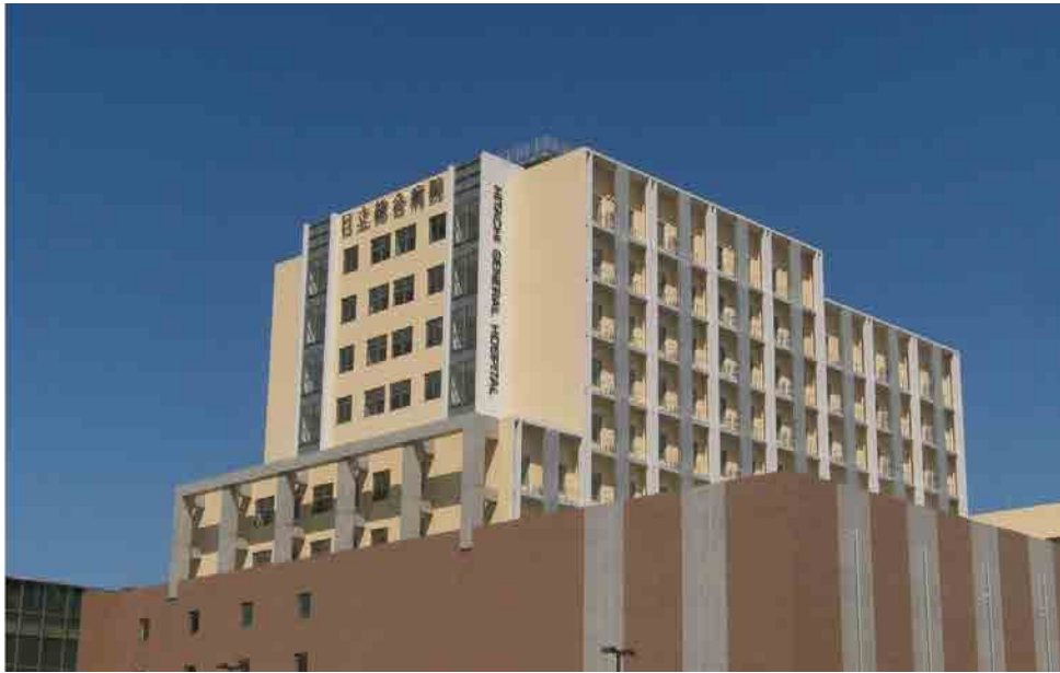
日立総合病院本館棟 外観
