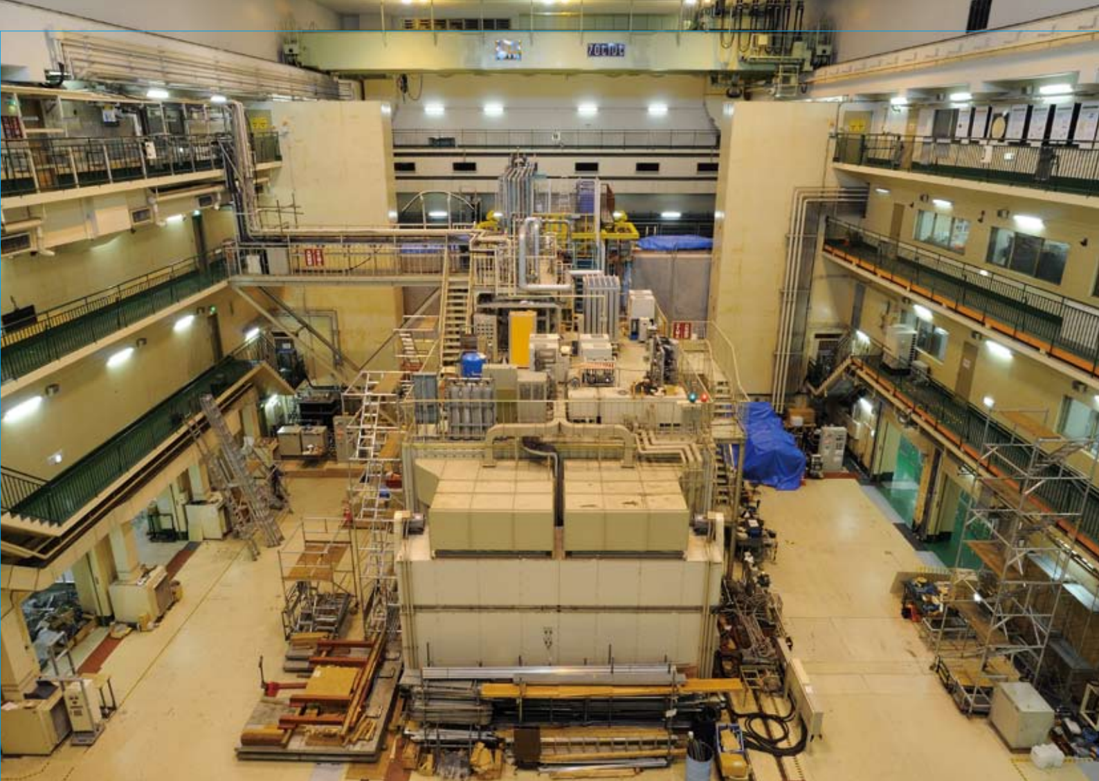
Bファクトリー筑波実験棟の内部の様子。奥に稼働中の測定器がある。
