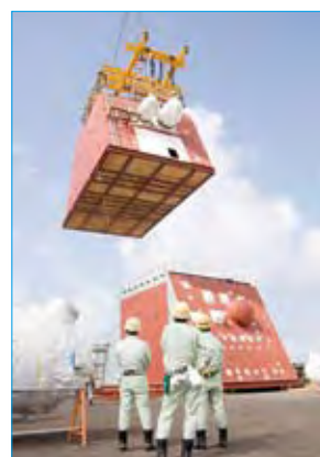
世界最大級の可動式クレーンで復水器上部を下ろす。
