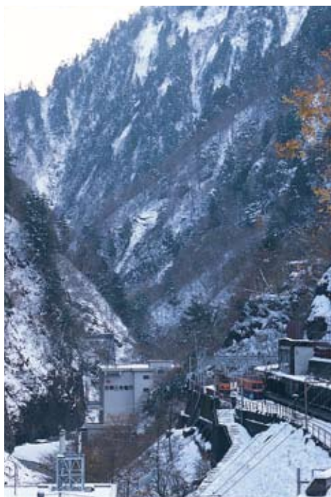
終点の樺平は雪景色だった。中央に見えるのは黒部川第三発電所。
