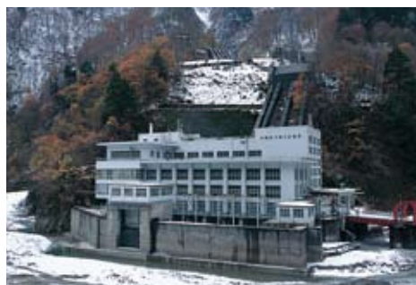
著名な建築家、山口文象がデザインした黒部川第二発電所。
