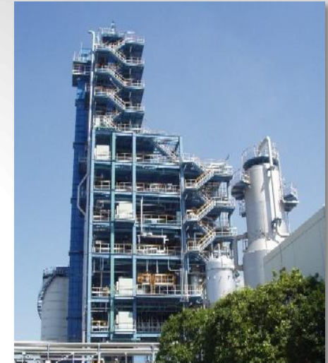
使用済みプラスチックを原料としたアンモニアプラント
