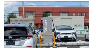
マルチポートEVチャージャ (Workplace E-Powering)
