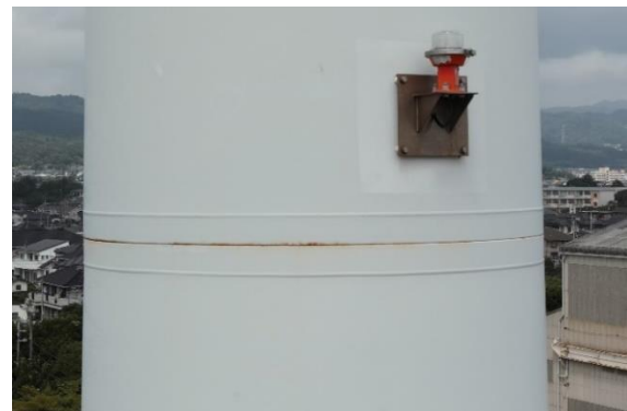
主な点検対象のタワー溶接部分
