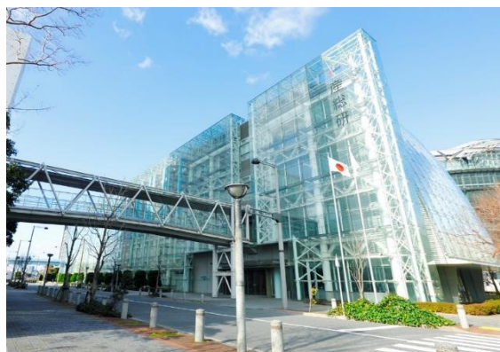
ラボを設立する産総研臨海副都心センター(本館) 外観
