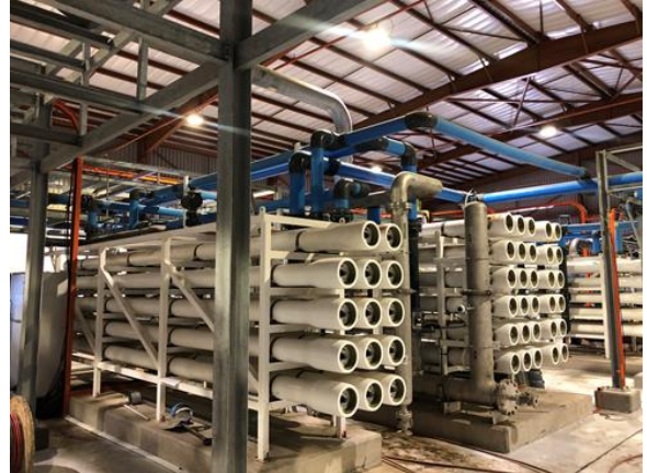
海水淡水化・水再利用統合システム(RO膜)
