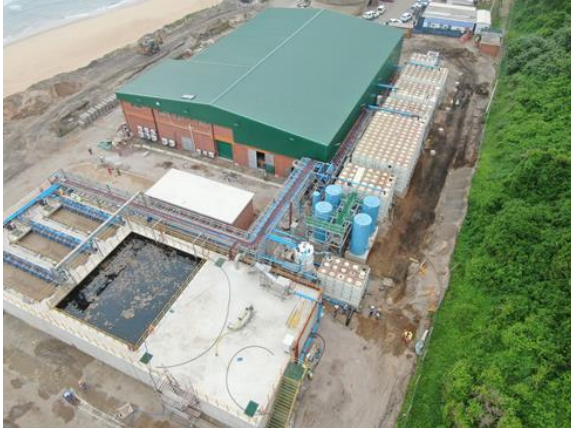
ダーバン市中部の下水処理場実証サイト (2019年11月末時点状況)
