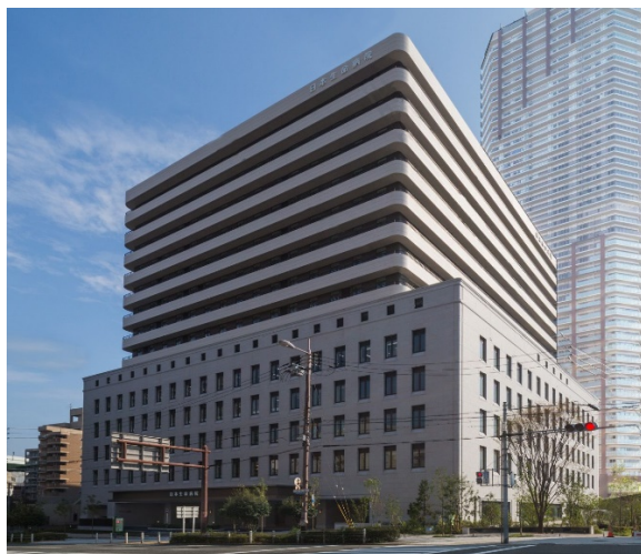
日本生命病院外観
