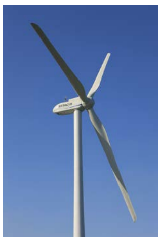
2MW 風車写真
