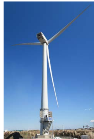
5.2MW 風車全体像
