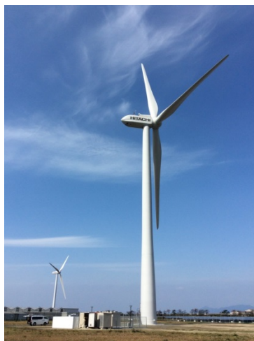
「エネ・シード北九州風力発電所」
