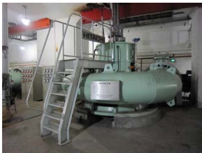
納入した大型ポンプ
