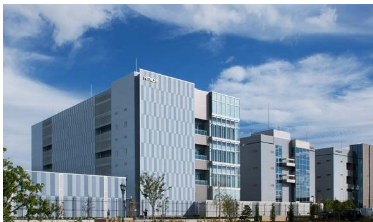
「岡山センタ」の外観（向かって左手が第3センタ）
