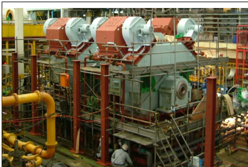
電気推進装置(推進用電動機2式(1軸分)) 社内組み合せ試験の状況
