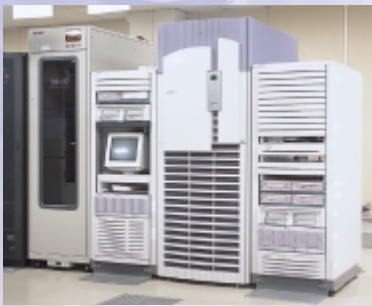
大型計算機センターのコンピュータールーム内。
