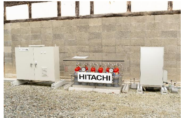
(写真左)浪江町の大堀防災コミュニティセンターに設置された水素充填・燃料電池設備 (写真右)一般家庭に設置された小型シリンダー(中央)と純水素型燃料電池(右)
