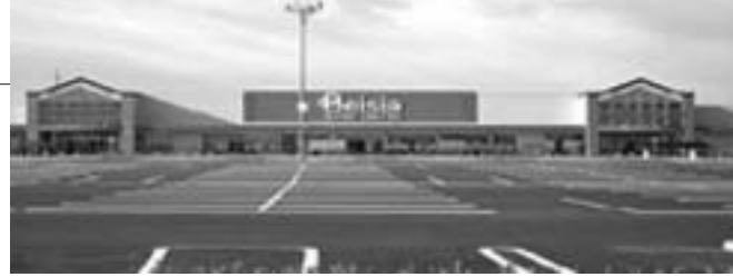
写真 - 1 スーパーセンター
