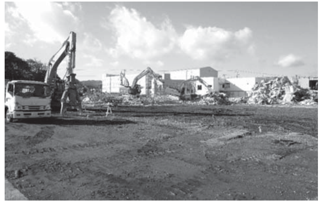
多賀クリニック（診療棟跡地）
