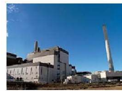
石炭火力発電 プラント*
