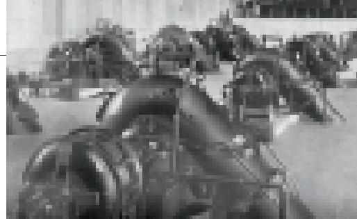
東京都芝浦污水処分場 渦巻ポンプ (口径910mm) 1933年
