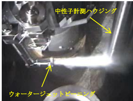
図7 炉内工事例 「原子炉内の応力腐食割れを予防する画期的な新技術」 (日立評論 2006年1月号)より引用
