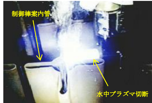
図8 動力試験炉の解体実地試験例 「動力試験炉の炉内構造物解体実地試験」 (日立評論 1990年1月号)より引用
