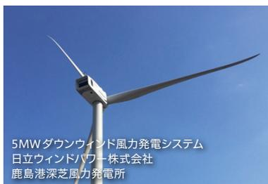
5MWダウンウインド風力発電システム
