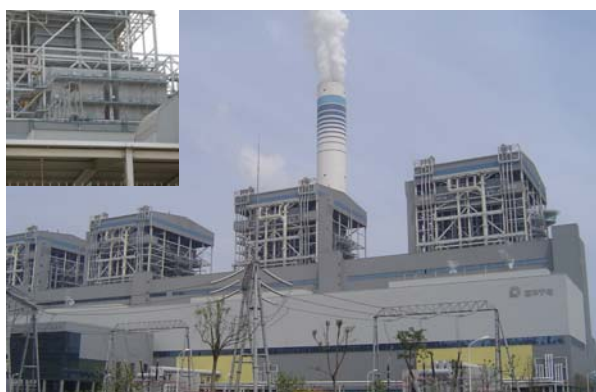
図 2.1 中国の寧海発電所 排煙脱硝装置(左上拡大図)
