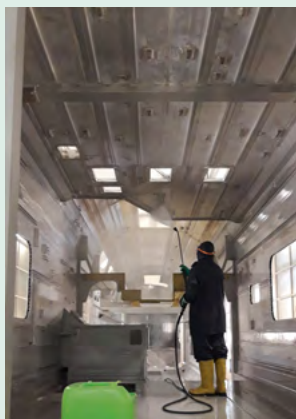
VOCフリーの溶剤を用いた塗装前の脱脂工程
