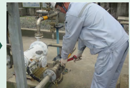
漏えい箇所の修理 (Repair)
