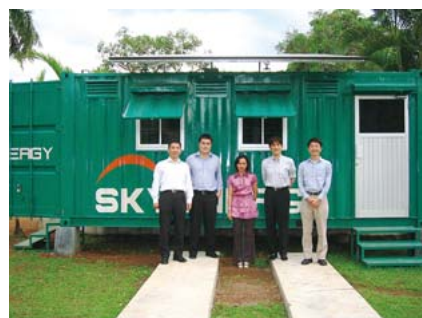
バッテリーチャージングステーション
