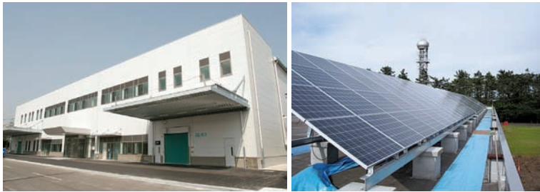
写真：(株)日立産機システム 習志野事業所 (左)断熱強化ガラスや省エネ機器を導入した新生産棟 (右)生産棟の屋根に設置した太陽光パネル
