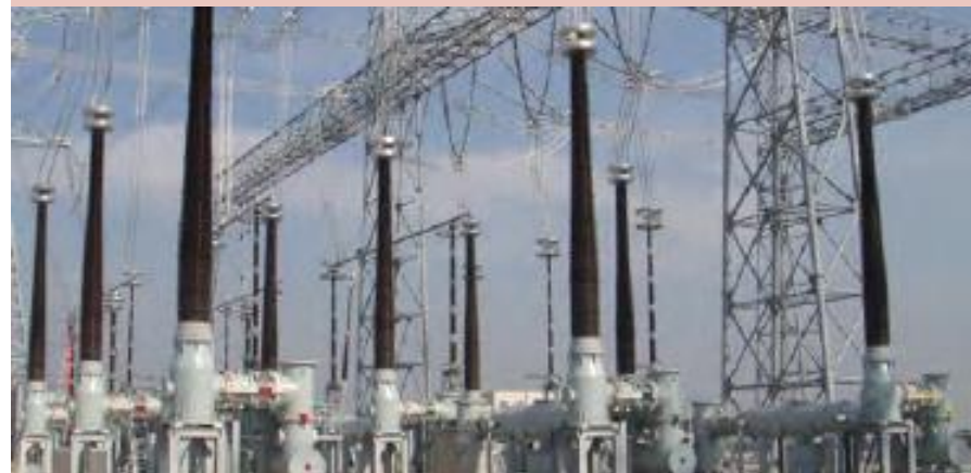
超々高電圧ガス絶縁開閉装置
