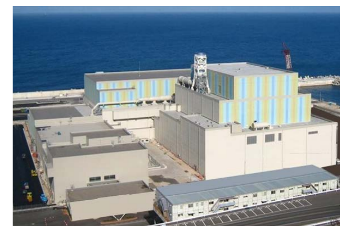
中国電力(株) 島根原子力発電所3号機(建設中)
