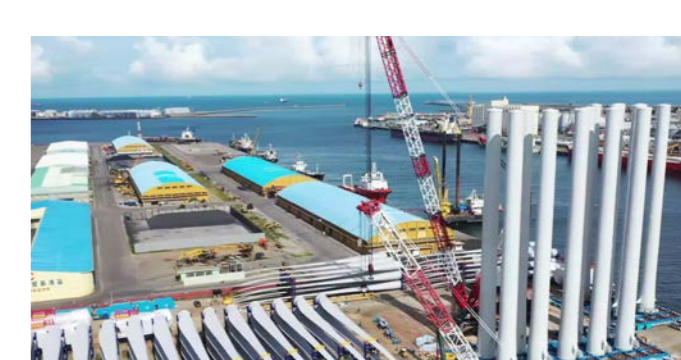
台湾・彰化洋上風力発電プロジェクトの台中港でのプレアセンブリ作業
