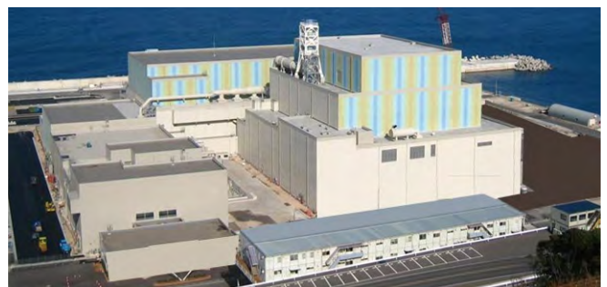
中国電力株式会社 島根原子力発電所3号機(建設中)
